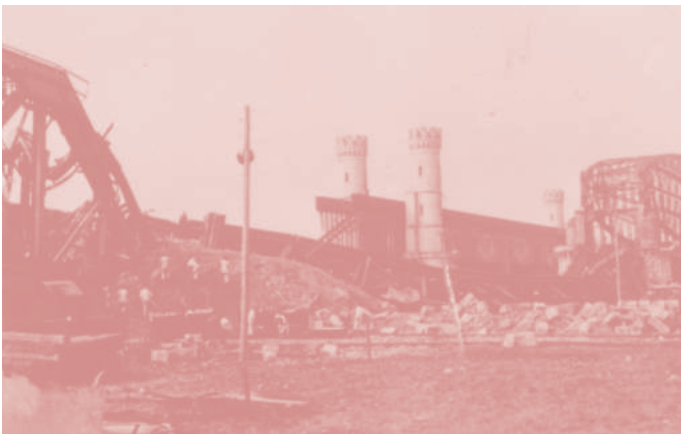
FOT. 22 Prace przy odgruzowywaniu uszkodzonego stalowego przęsła, 8 września 1939 r. (AIPN)
