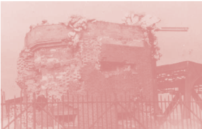
FOT. 21 Ruiny służącej jako bunkier podpory mostu przez Wisłę w Tczewie, 8 września 1939 r. (AIPN)
