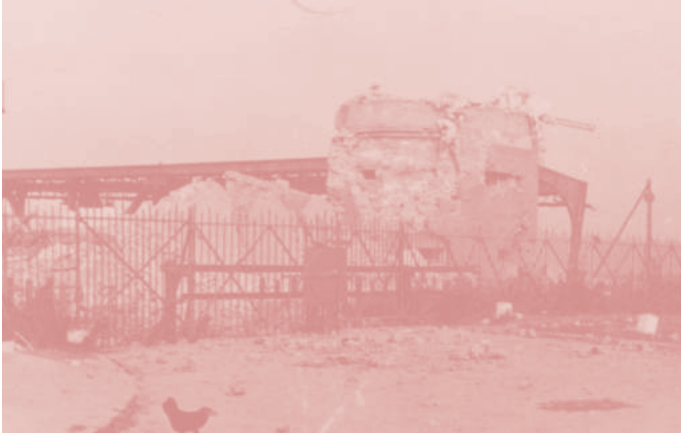
FOT. 20 Ruiny podpory mostu kolejowego przez Wisłę w Tczewie, 8 wrze- śnia 1939 r. (AIPN)
