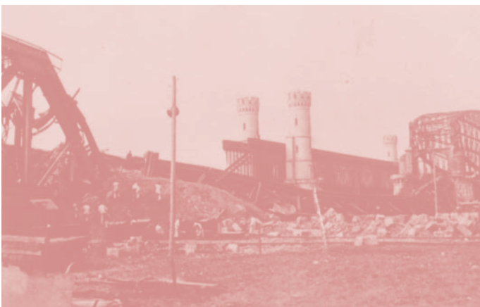
FOT. 22 Prace przy odgruzowywaniu uszkodzonego stalowego przęsta, 8 września 1939 r. (AIPN)
