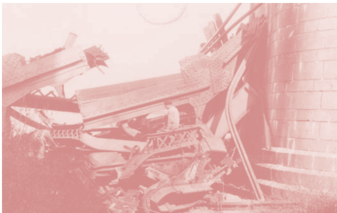
FOT. 4 Zniszczone fragmenty stalowej konstrukcji mostu w Tczewie, 8 września 1939 r. (AIPN)
