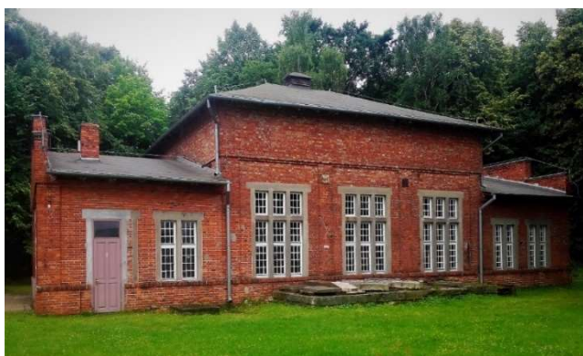
Ryc. 1. Budynek elektrowni na Westerplatte. Stan obecny, fot. MIIWŚ
