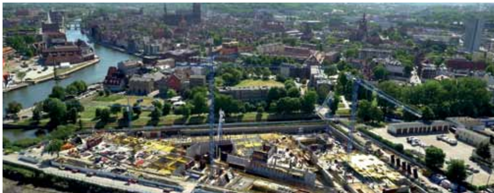
Budowa Muzeum z lotu ptaka. Czerwiec 2015 r. Fot. AeroLab
