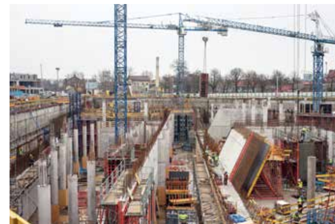
Prace żelbetowe – budowa ścian, słupów i stropów
