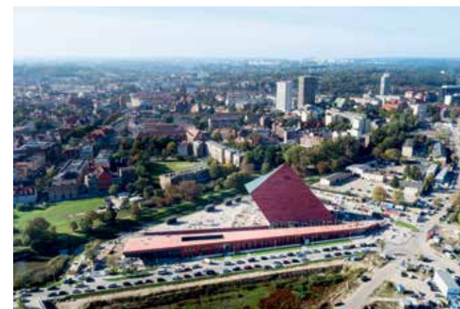
Zakończenie montażu czerwonej okładziny na budynku Muzeum
