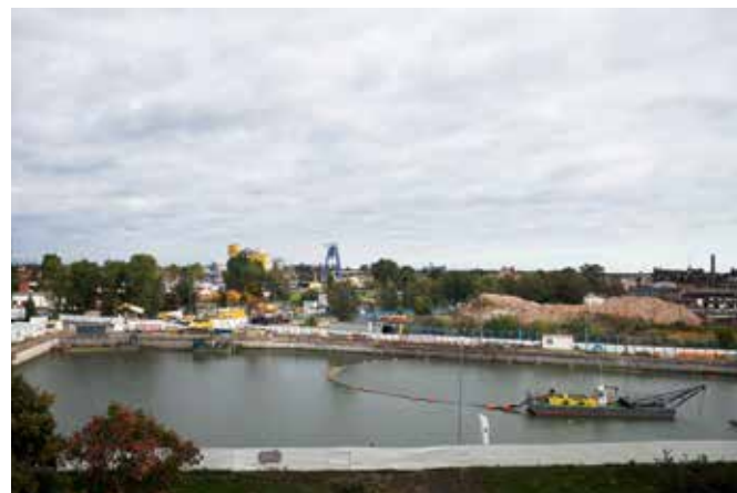
Pogłębianie wykopu metodą refulacji
