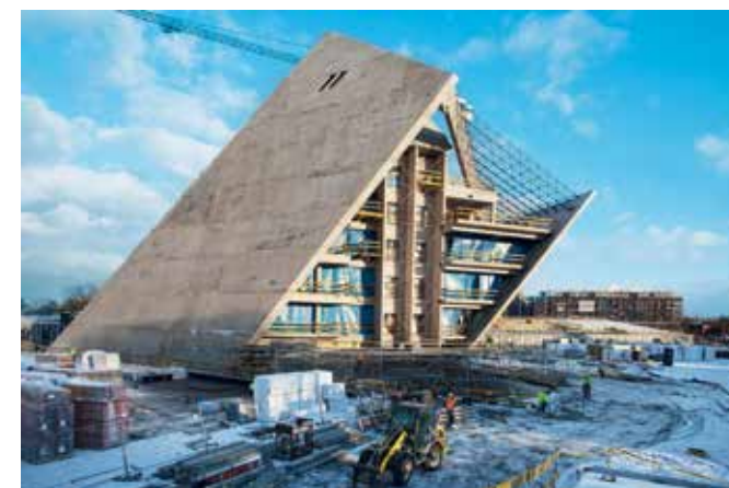
Ukończona wieża Muzeum – przygotowanie do montażu szklanego świetlika i fasady
