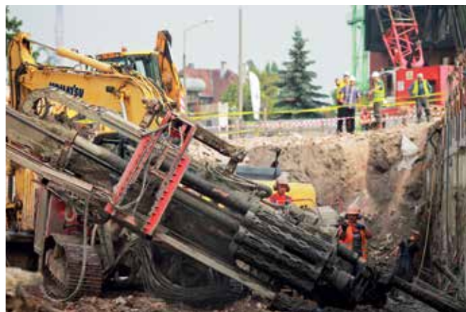
Instalacja kotwi stabilizujących przy ścianach suchego wykopu
