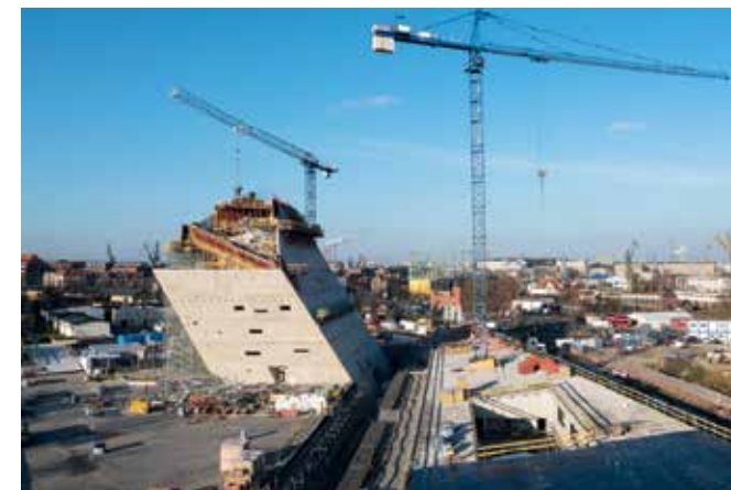
Wylanie stropu i budowa wieży
