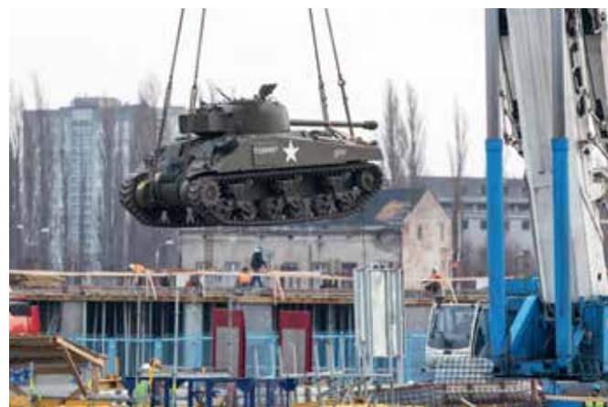
Wielkogabarytowe eksponaty, w tym amerykański czołg Sherman Firefly, umieszczane na płycie fundamentowej
