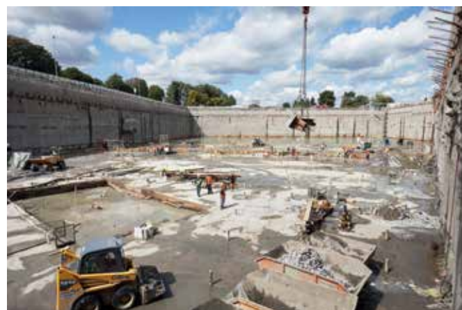
Czyszczenie i wyrównywanie dna betonowego korka po wypompowaniu wody
